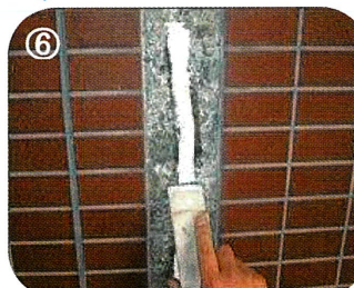
ウレタンシーリングを充填し平滑に均す ※肉やせを考慮して充填は多めに
