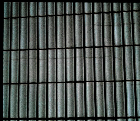
施工前タイルひび割れ状況
