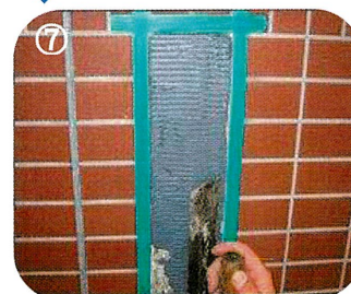
周辺タイルをマスキング養生 弾性接着剤を下地表面に塗布
