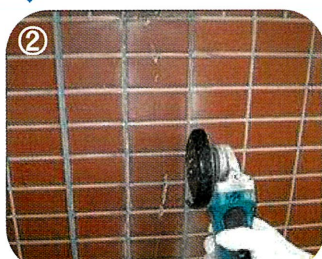
グラインダーでクラックタイルの目地部に カッター入れ
